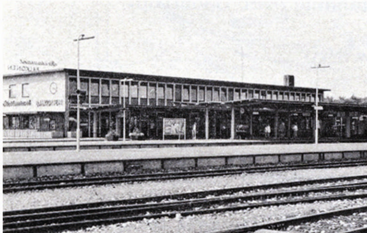
Fig. 10: Nykøbing Fl. stationsbygning.
