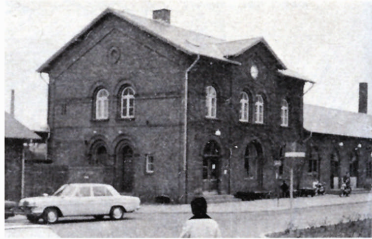
Fig. 13: Køge stationsbygning fra gaden.
